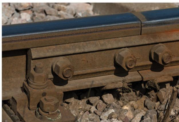
**6** Separación de vías del tren para evitar el pandeo de éstas en caso de dilatación térmica.
