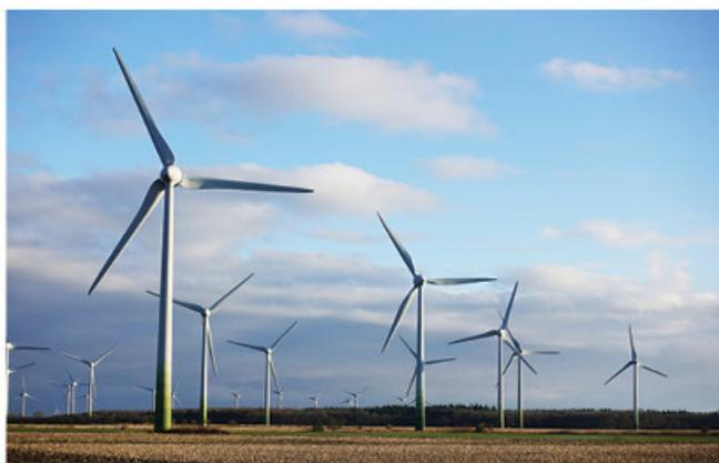
**Aerogeneradores o generadores eólicos:** utilizan la energía cinética del viento que sopla de las zonas de alta presión a las de baja presión para mover aerogeneradores conectados a los alternadores (generadores de corriente alterna). Esta forma de obtención de electricidad tiene mínimo impacto ambiental, si bien genera ruido en su proximidad y puede provocar la muerte de aves por golpes con las aspas. **20**
